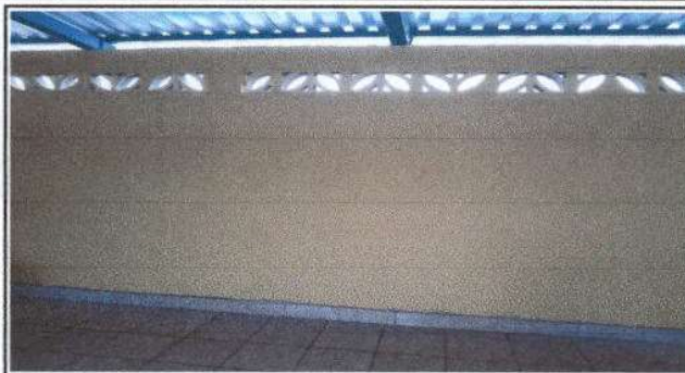
Foto 2: Repello en muro en cocina
