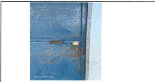
Foto 6: sustitución de chapas de la puerta de la Escuela
