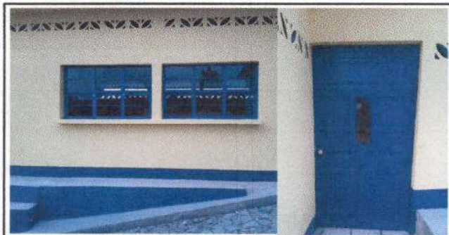
Foto 5: Sustitución de Ventanas y puerta en cocina
